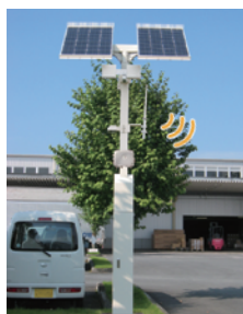
観光・防災 Wi-Fi ステーション
