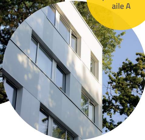
Après travaux aile A
