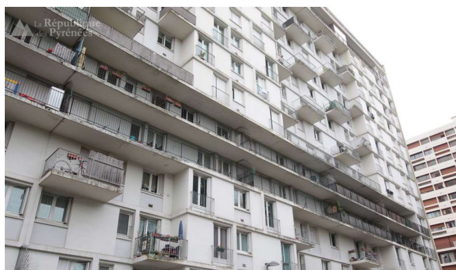
©larepubliquedespyrenees.fr (Logement social à Pau : la fusion des deux offices HLM est en projet)
