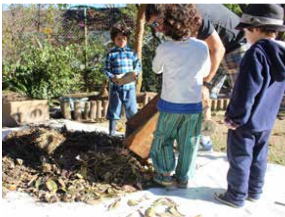
Terra, esterco e folhas: tudo misturado com água para fazer a "massa" das paredes da casa
