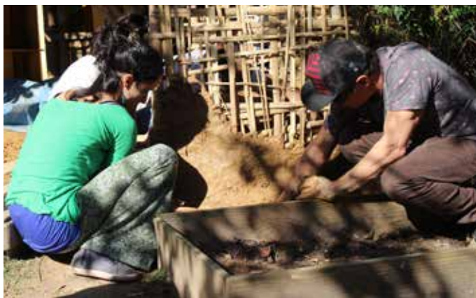
Terra, esterco e folhas: tudo misturado com água para fazer a "massa" das paredes da casa
