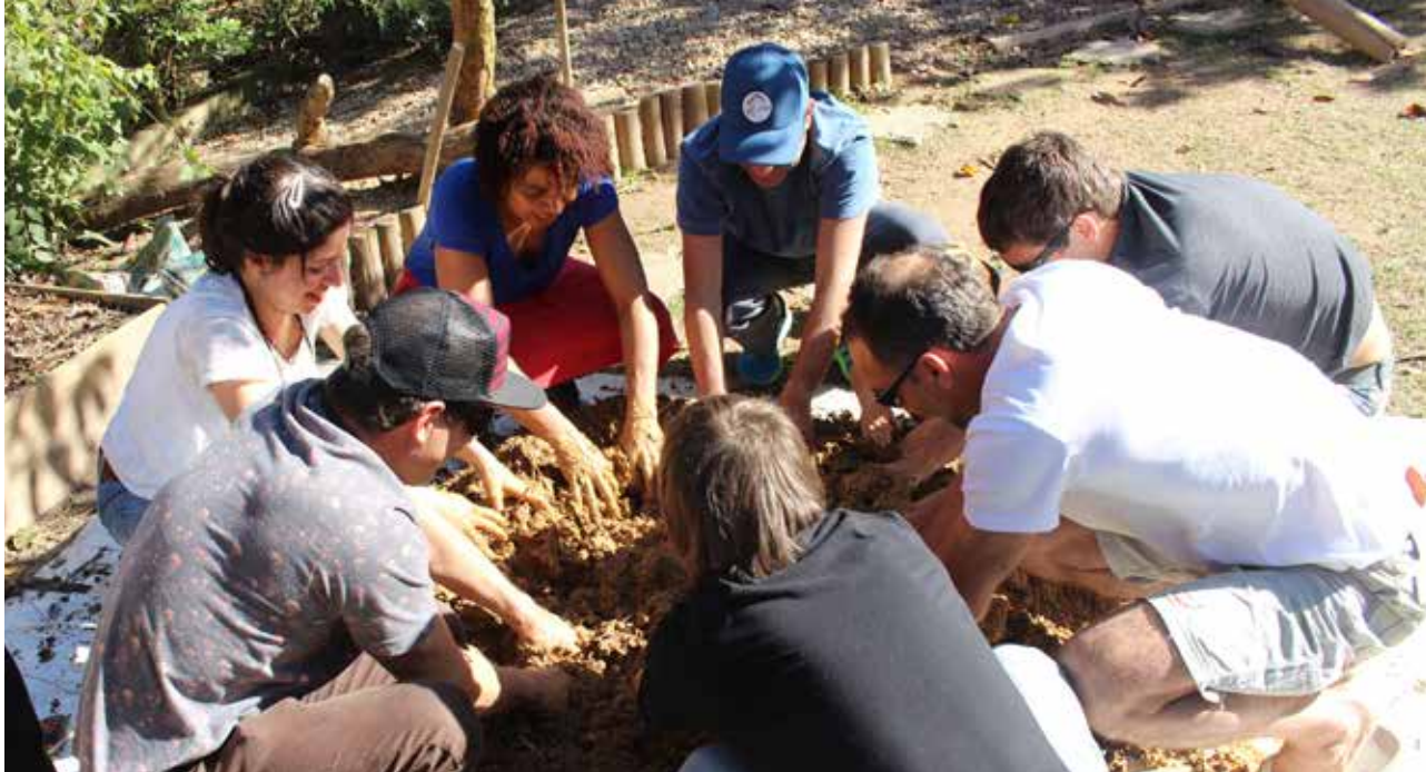
Terra, esterco e folhas: tudo misturado com água para fazer a "massa" das paredes da casa
