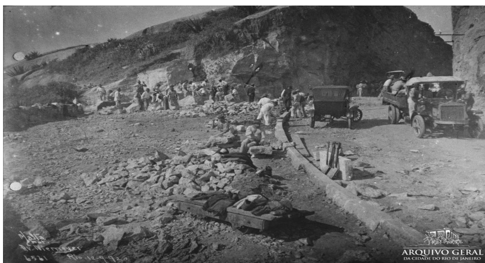
Figura 50 - Obras na avenida Niemeyer
