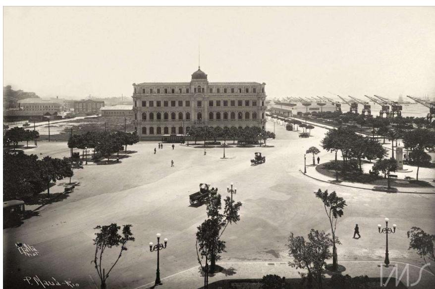
Figura 40 - Colocação dos postes elétricos
