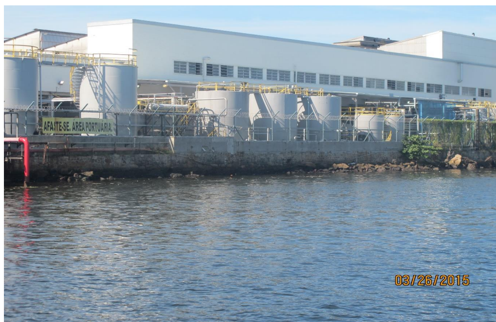
Figura 1 - Instalações da petroquímica COSAN, com a placa indicativa de proibição de aproximação (AFASTE-SE, ÁREA PORTUÁRIA). Foto tirada pelo autor no dia 26 mar. 2015 ocasião da denúncia acerca do crime ambiental, que despejou substâncias químicas in natura na baía de Guanabara, causando a mortandade de diversas espécies de peixes e invertebrados.
