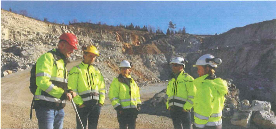
Foto 1. Uttak av fjellmasser til pukkproduksjon foregår etappevis.
