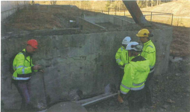
Foto 4. Innløp til sedimenteringsbassenget
