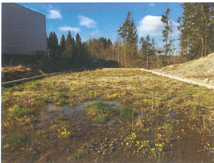
Foto 6. Tilplantet grusfilter sett fra innløpsenden
