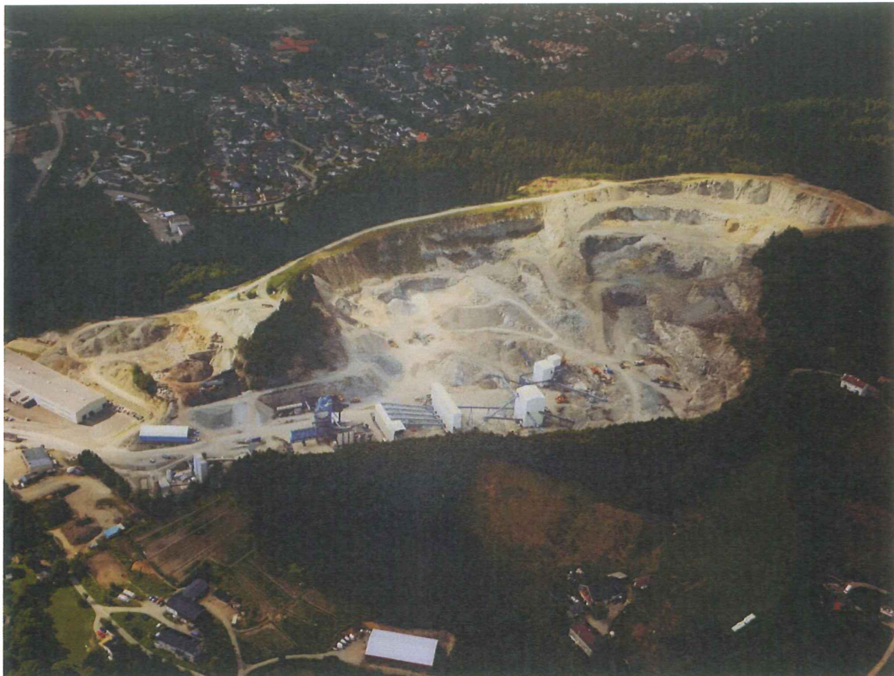
Figur 1. Oversiktsbilde av pukkverket på Lierskogen.
