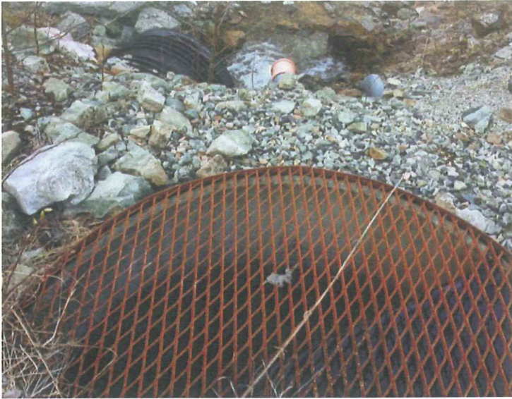
Foto 7. Nivåkum ut av filteranlegg og utløp av overløpskulvert
