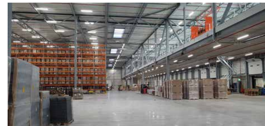
Hoge vlakheden zoals FM2 Special (Free Movement), DIN 15.185 voor smalle gangen magazijnen of NEN 2747 klasse 2, het zijn geen uitzonderingen voor Twintec.
