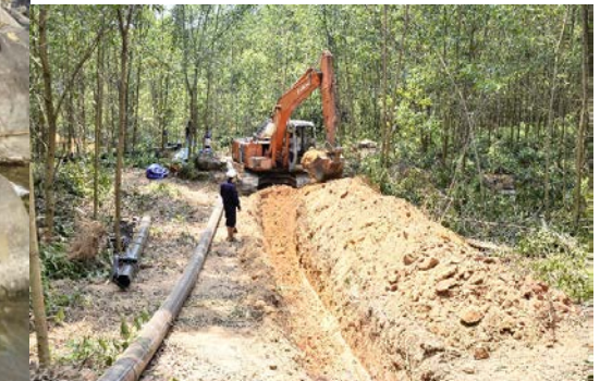
T/c tuyến D400-300 gang nước thô Đập Khe Mệ - Pauger (T3-5/2020)
