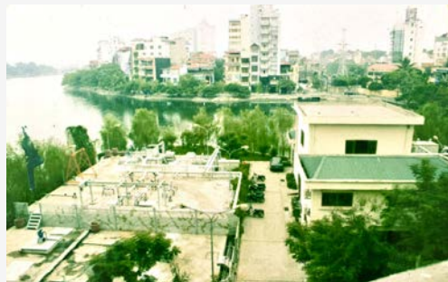
Trạm xử lý nước thải Trúc Bạch
