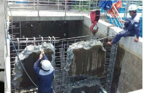
T/c nâng cấp cải tạo bể lắng NM Phong Thu từ 8.000m 3 /ngđ lên 16.000m 3 /ngđ (T3-5/2020)
