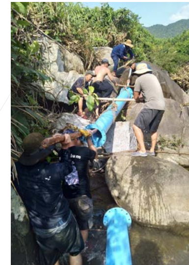
T/c tuyến D400-300 gang nước thô Đập Khe Mệ - Pauger (T3-5/2020)
